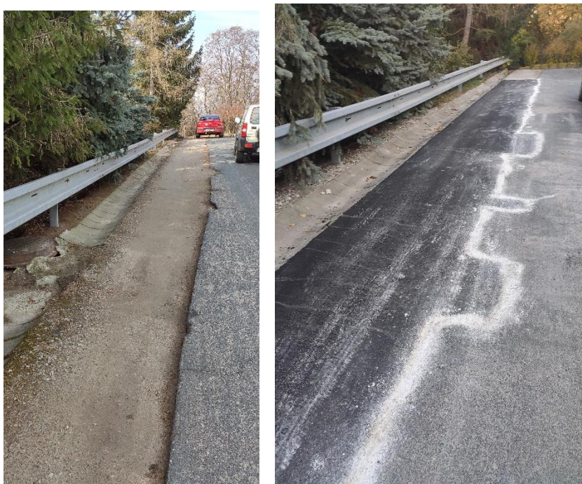
(oprava komunikace na Klínkách)
