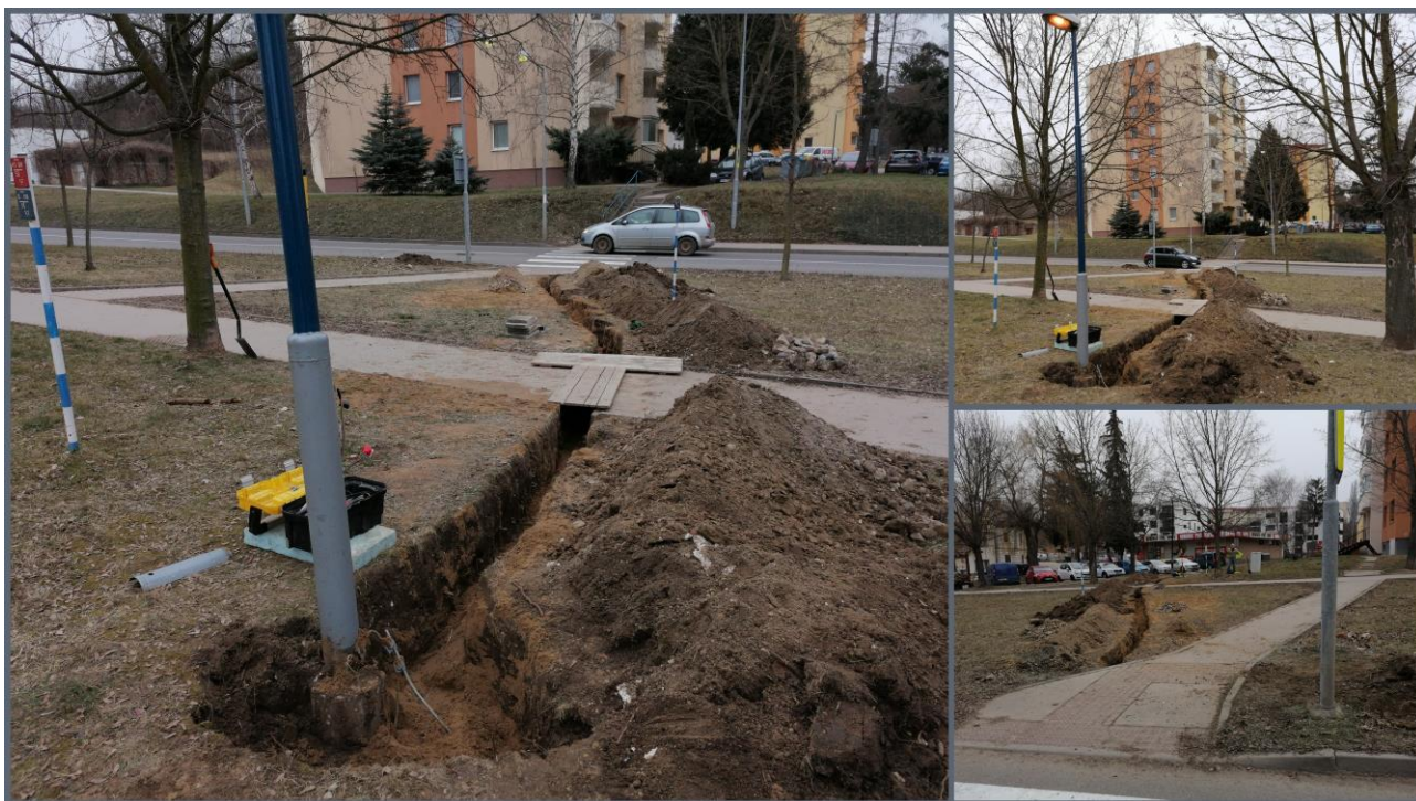
Ul. Brandlova přeložka kabelu a příprava pro nové napojení osvětlení, které je v plánu na rok 2022.
