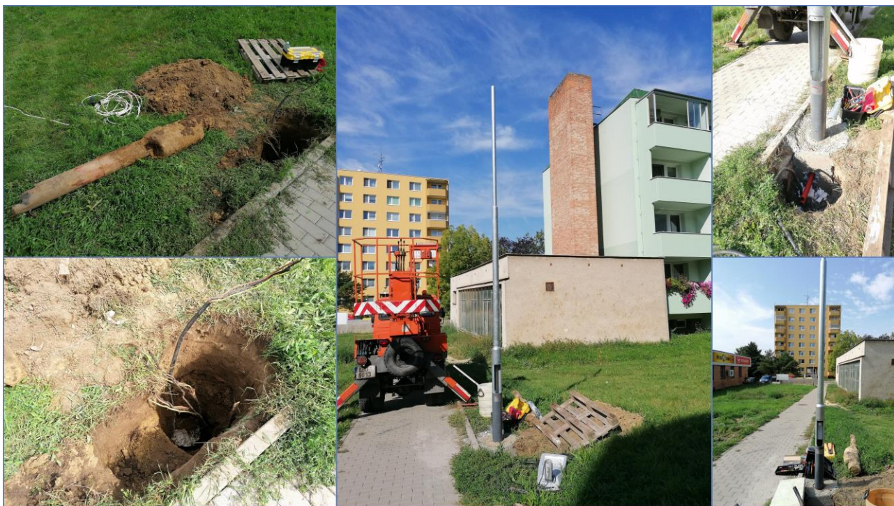
Výměna uhnílého stožáru mezi hřištěm a obchodem U Vodojemu.
