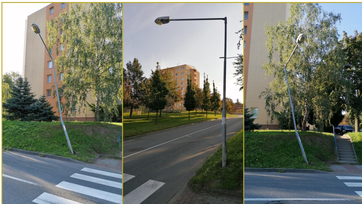
Přechod pro chodce ul. Brandlova u kruhového objezdu. Proběhla výměna nového stožáru a oprava kabelů.
